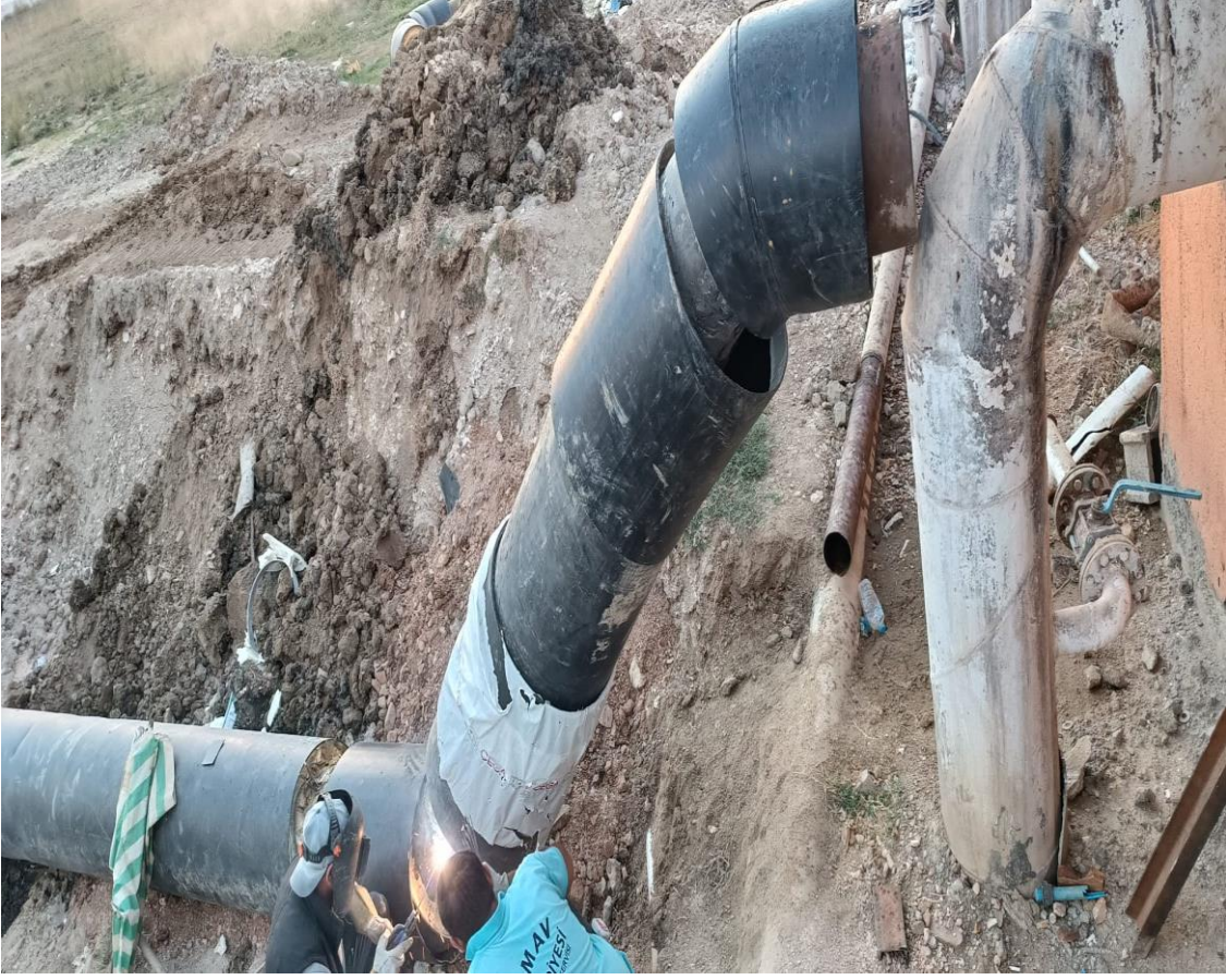
*Esenevler Mahallesi 12.sokak [DN65] 140 metre paket çelik boru yeni hat çekilmesi
