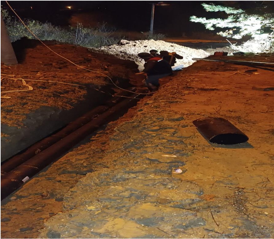
*Yeşilova Isı Merkezi Yenileme Çalışması
