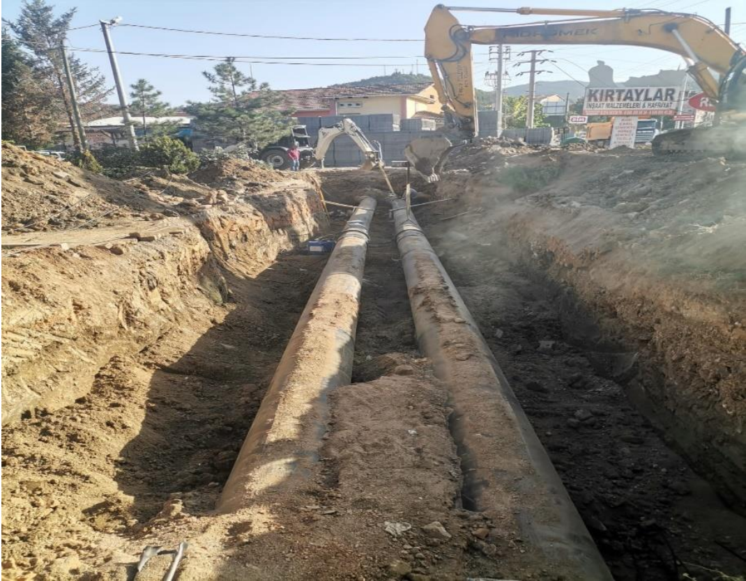
*Ej1 kuyu başı ve garaj ısı merkezi arası yeni hatta geçme ön hazırlık çalışması
