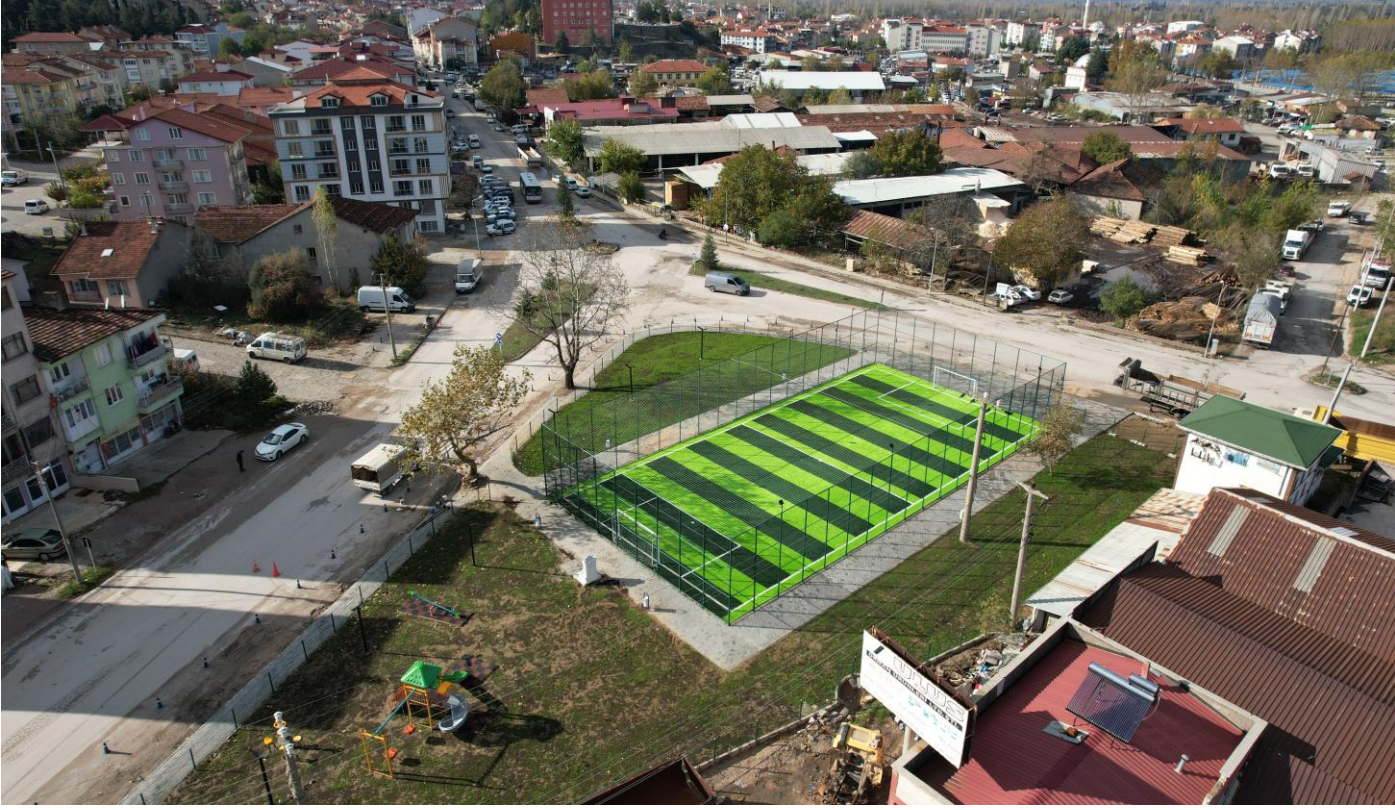
İlçemiz Kekliktepe Mahallesi Sentetik Çim Yüzeyle Futbol Sahası Yapımı Tamamlanmıştır.
