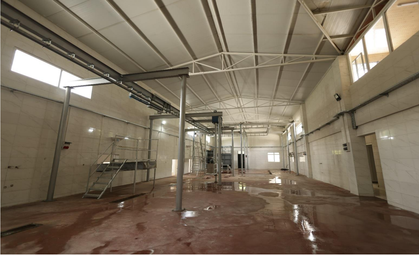
İlçemiz Mezbahanesinin Yeniden Yapımı
