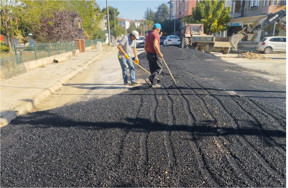
İlçemiz muhtelif caddelerinde asfalt yapım çalışmaları
