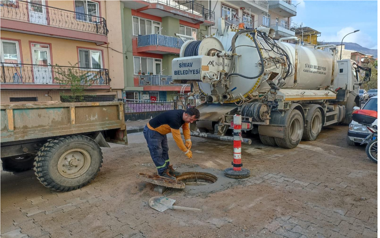
İlçemiz içerisindeki rögarların bakım çalışmaları
