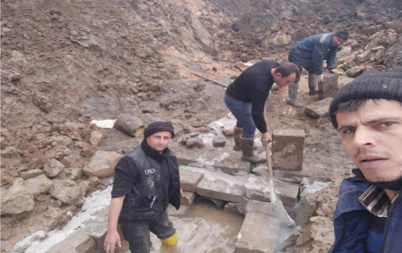
4-Nadarcam Gebeoluk ve Demirboku Mevkiilerinde yaptığımız hat tenileme faslak yapımı çalışmaları.
