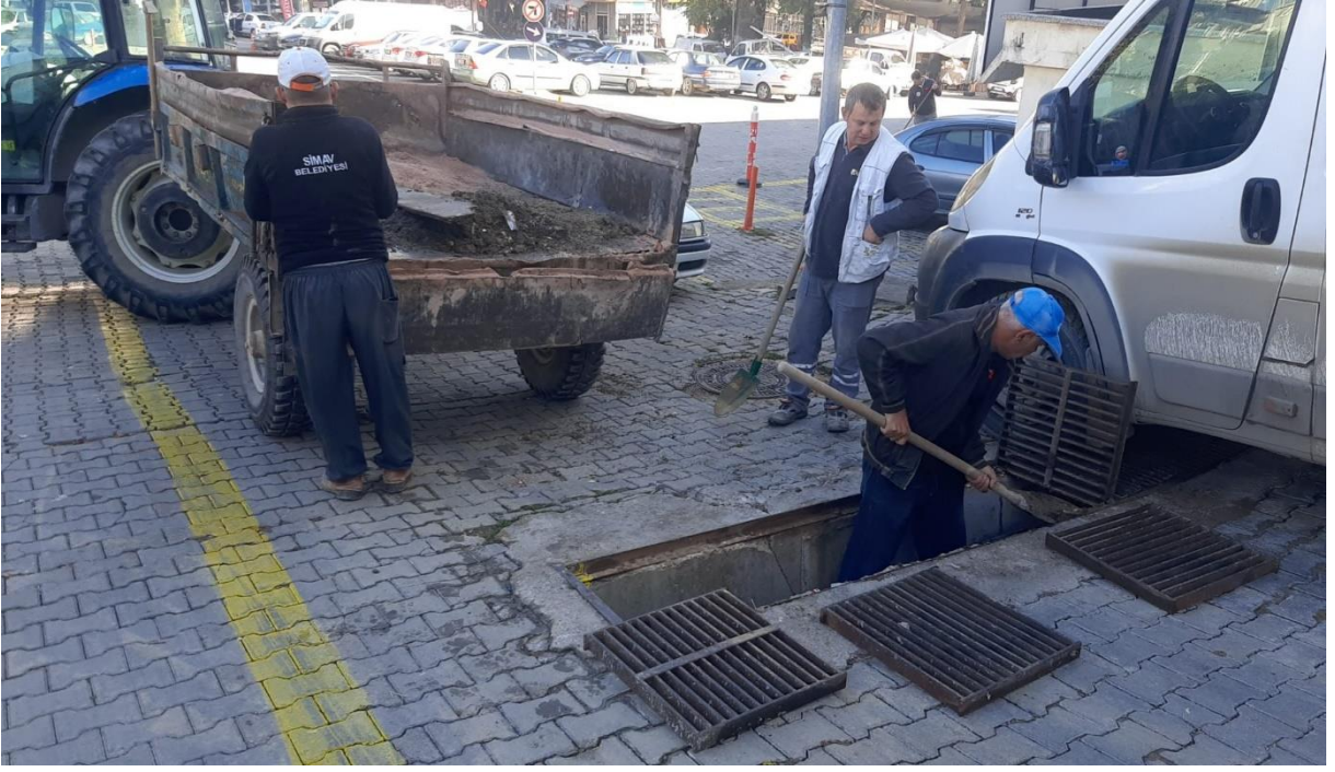
İlçemiz içerisindeki mazgaları temizleme çalışmaları
